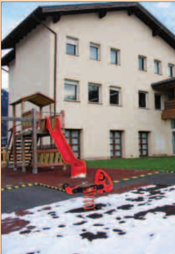
La sede della Scuola Primaria di Fierozzo/Vlarotz
