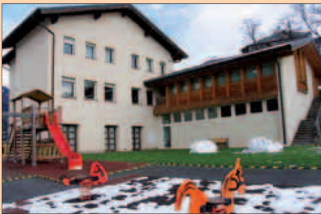
La sede della Scuola Primaria di Fierozzo/Vlarotz
