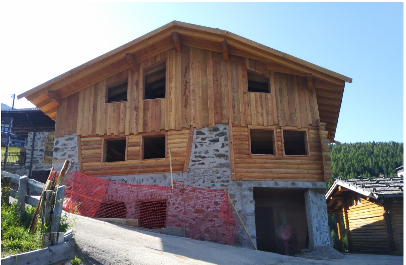
Rifacimento copertura mulino Istituto Culturale Mocheno e restauro abitazione a Fierozzo
